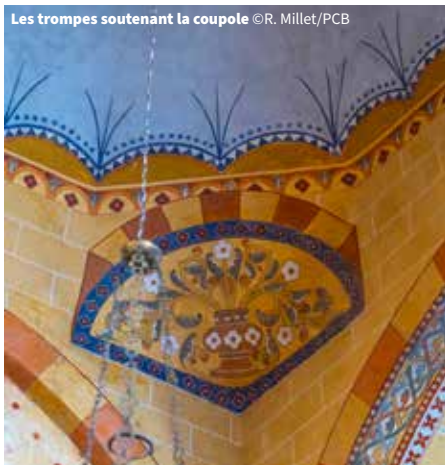
Les trompes soutenant la coupole ©R. Millet/PCB
