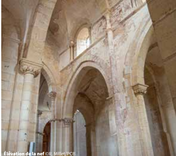
Élévation de la nef ©R. Millet/PCB
