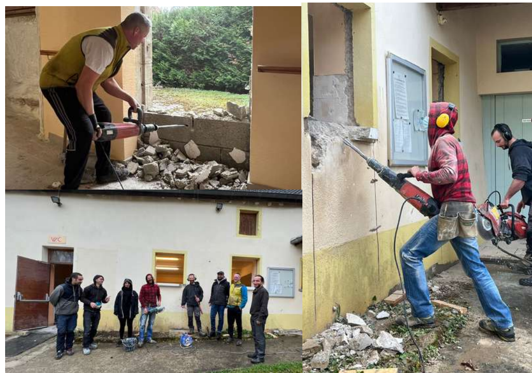
CHANTIER PARTICIPATIF LORS DES TRAVAUX DE L'AGORA MARS 2023 - 2 JOURS / 10 PERS
