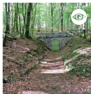
POINT DE DÉPART DU TUNNEL DE CAPTAGE DES EAUX DU RANÇON POUR L'ACHEMINEMENT AU CREUSOT
