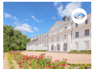
CHÂTEAU DE LA VERRERIE
