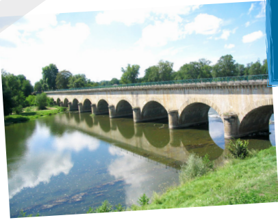
Pont-canal de Digoin
