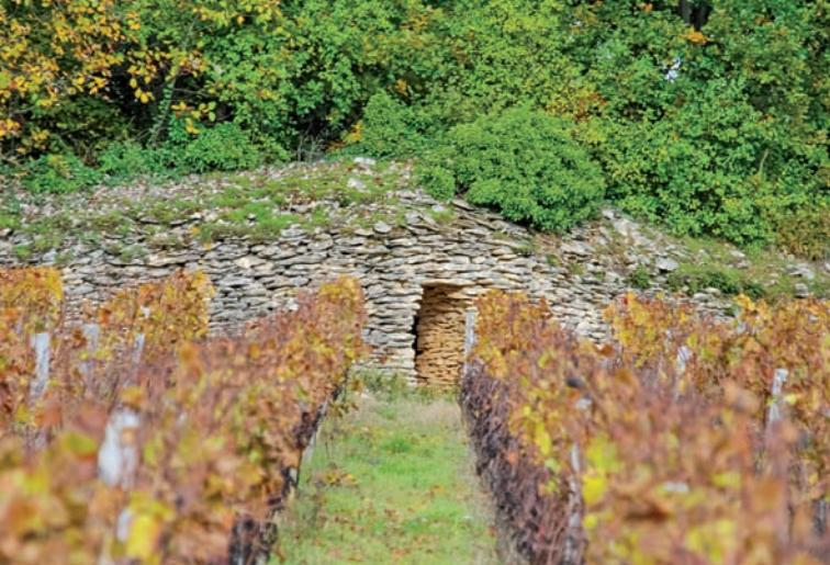
Inserée dans le murger, la cadole est construite en pierre sèche, avec la technique de la fausse voûte en encorbellement.
