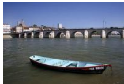
Mâcon : pont de Saint-Laurent © ADT71/Chocat Lyonel
