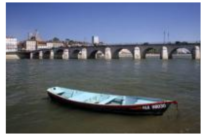
Mâcon : pont de Saint-Laurent © ADT71/Chocat Lyonel
